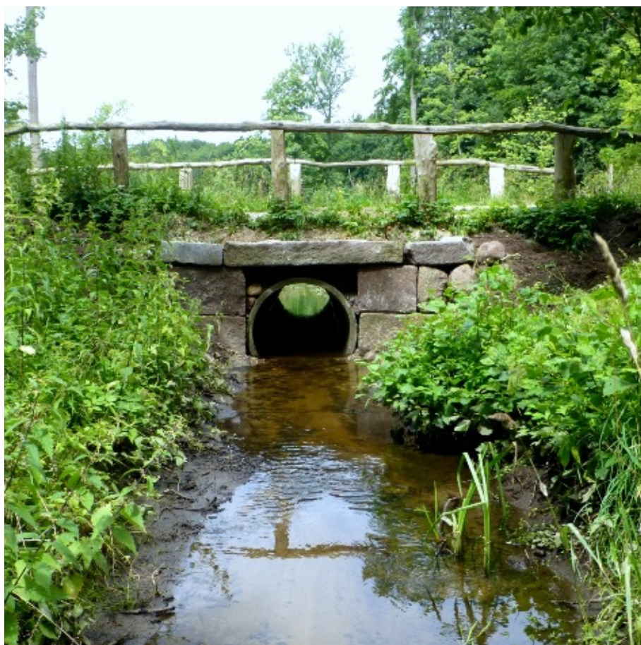
Harevad bro efter restaurering.
